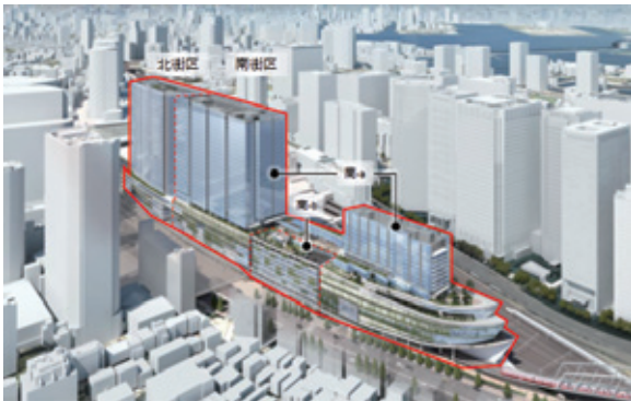
海の近くで発展してきた品川にふさわしく船を思わせるデザインとなる駅街区。北街区は東日本旅客鉄道、南街区(a、b)は京急グループが主体となり事業を推進している。
