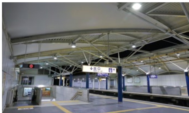
人の目にやさしいLED照明を導入し消費電力を削減した京急久里浜線 YRP 野比駅のホーム。
