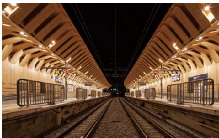
23区内初の木造駅舎となった戸越銀座駅には多摩産の杉材が使われている。
