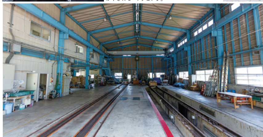
阿佐海岸鉄道本社と一体となっている車庫内。右の線路の下から点検作業ができるようになっている。
