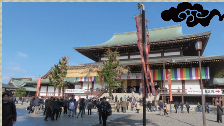
新勝寺大本堂に安置される成田不動尊は、もとは京都の神護寺にあったが、平将門の乱を平定するために当地に遷されたのだという。その靈験で乱は鎮定され、「新たに勝つ」お寺が創建された。
