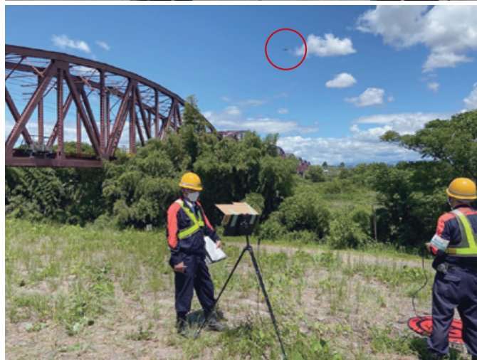
上/天白川橋梁でドローンを使った点検 下/木曾川橋梁でドローンを使った点検
