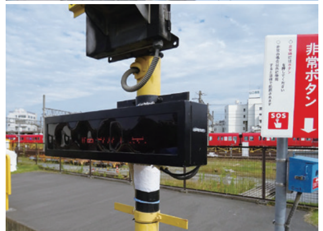
上/踏切を監視するカメラ 下/踏切AI画像解析と連動した注意喚起LED
