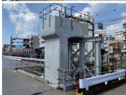
上／ホームドア 中央／転落防止固定柵 下／連続立体交差事業の工事風景
