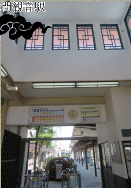
駅舎中央の塔を内部から見上げたところ。祀崩しの棧がついた明かり窓が印象的。寺院の伝統的な意匠を使いながらも大正モダンの雰囲気漂う。
