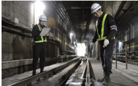
左/バラスト撤去・防振まくらぎ敷設工事 上/レール削正車 下/線路の安全性を点検する徒歩巡回 右/剛体電車線トロリ線張替作業（写真提供：東京メトロ）
