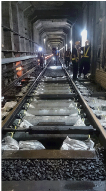
左/バラスト撤去・防振まくらぎ敷設工事 上/レール削正車 下/線路の安全性を点検する徒歩巡回 右/剛体電車線トロリ線張替作業（写真提供：東京メトロ）
