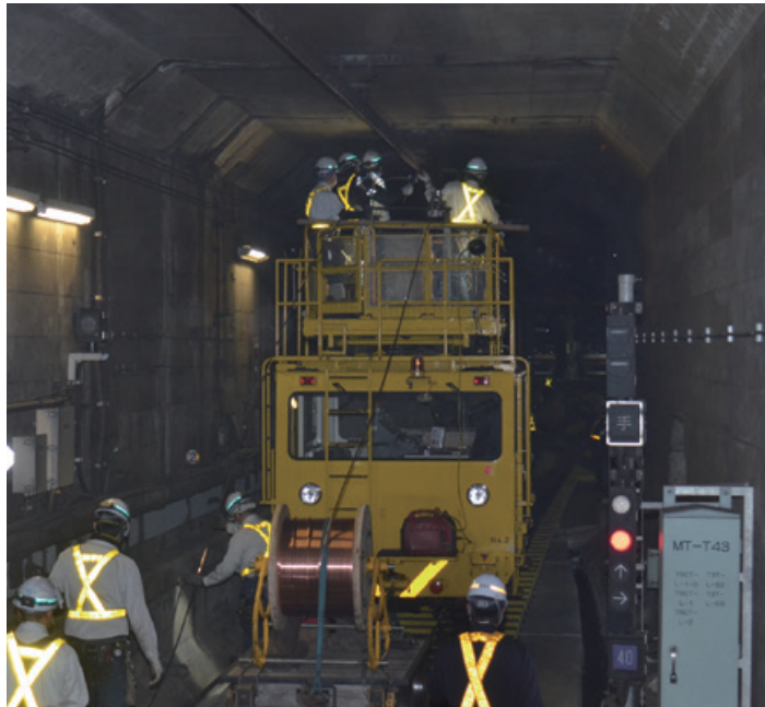
左/バラスト撤去・防振まくらぎ敷設工事 上/レール削正車 下/線路の安全性を点検する徒歩巡回 右/剛体電車線トロリ線張替作業（写真提供：東京メトロ）
