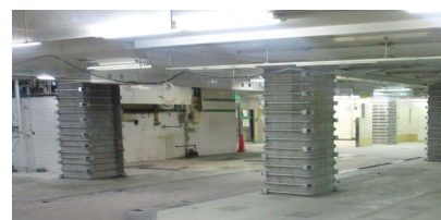
耐震補強工事実施済みの橋脚
