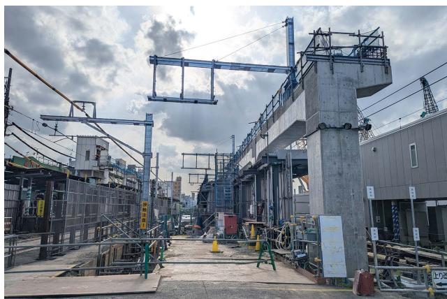
連続立体交差化工事(京成押上線)
