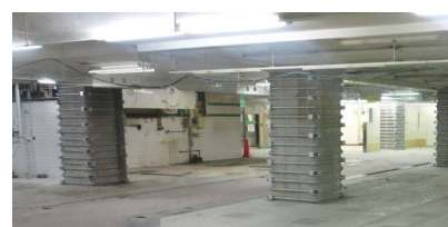
耐震補強工事実施済みの橋脚
