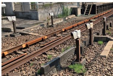
障害物検知装置(レーザー式)
