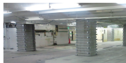
耐震補強工事実施済みの橋脚
