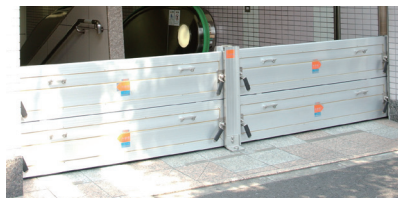
駅出入口の止水板
