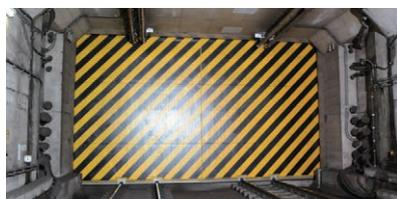
トンネルの断面を閉鎖する防水ゲート
