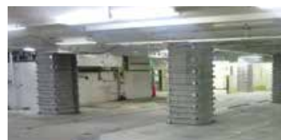
耐震補強工事実施済みの橋脚
