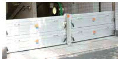
駅出入口の止水板
