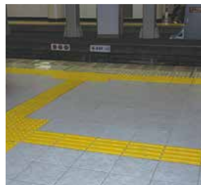
視覚障害者誘導用ブロック
