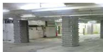
耐震補強工事実施済みの橋脚
