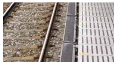
転落検知装置
