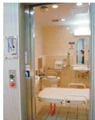
移動制約者用トイレ(個室)
