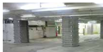
耐震補強工事实施済みの橋脚
