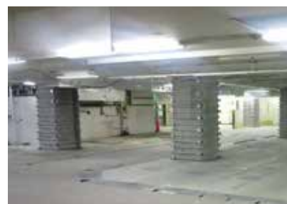
耐震補強工事実施済みの橋脚
