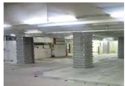
耐震補強工事実施済みの橋脚
