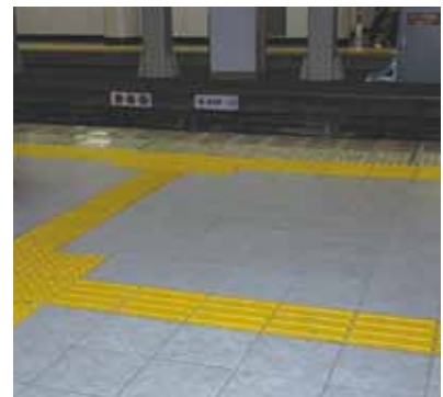
視覚障害者誘導用ブロック
